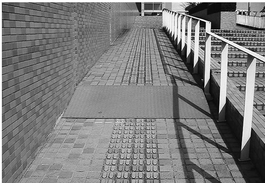
図2 屋外の階段に平行設置されたスロープ（特に途中の鉄板を含め、雨天は滑りやすい）
