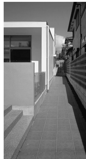
図8 車いすレベルまで対応した 玄関までのスロープ
