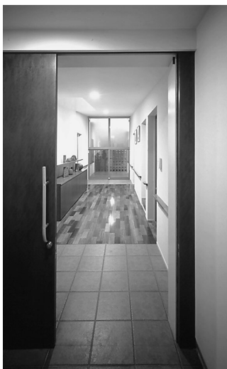
図5 上り框のない玄関から廊下への見通し 右手側に連続する“体を支える支持面”(手すり)
